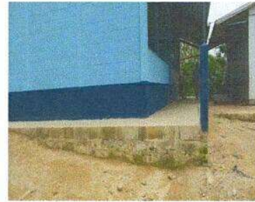
Foto 4: Sustitución de piso de torta de concreto en aula
